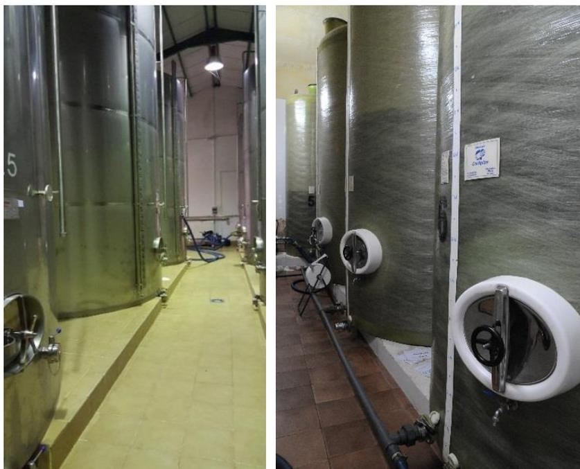
*Depósitos de almacenamiento de acero inoxidable (izquierda) y de fibra de vidrio (derecha)*
