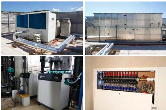
Las bombas de calor geotérmicas y el sistema de triple acristalamiento se emplean para proporcionar calefacción y frío activo al edificio, a través de dos depósitos de inercia y diversos grupos de bombeo; mientras que las UTA se emplean para acondicionar el aire interior del edificio, que se impulsa y extrae a través de conductos aislados y rejillas regulables. Todos estos equipos están monitorizados y controlados a través de un sistema de gestión centralizado (BACS).
