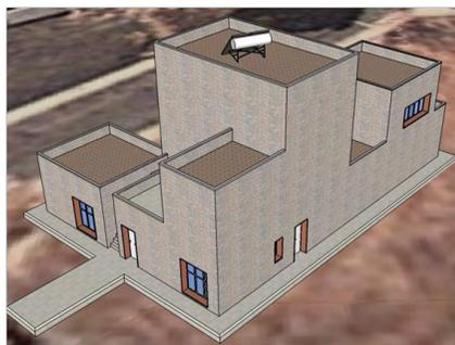
La estructura del edificio se resuelve mediante pórticos de hormigón armado. La cimentación se resuelve a base de zapatas corridas sobre las que descansan los muros de ladrillo que sostienen el forjado sanitario y zapatas aisladas que reciben los pilares, unidas entre sí mediante vigas de atado. La estructura vertical está formada por pilares de hormigón armado de 25x25cm y la horizontal por forjados unidireccionales de viguetas pretensadas y bovedillas cerámicas de canto 20+5cm.
